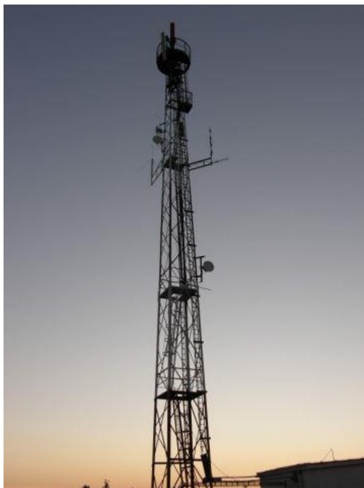
Fot. 1. TSR Trójca / g. Jaworów – widok obiektu
