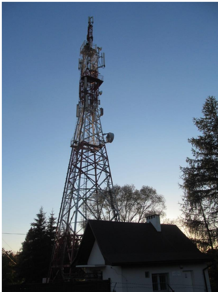
Zał. nr 1: Widok ogólny instalacji radiokomunikacyjnej.
