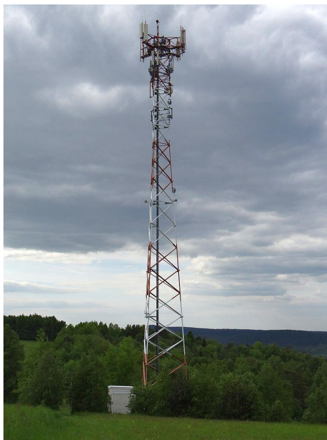
Fot. 1. BT_24444 WOJTKOWA – widok obiektu
